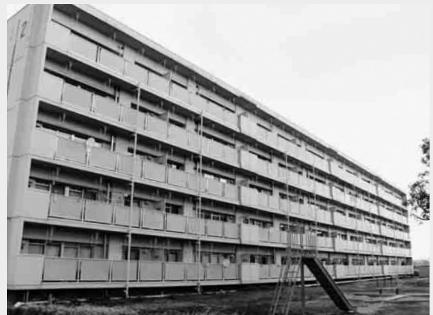
▲鹿島区定住促進住宅
